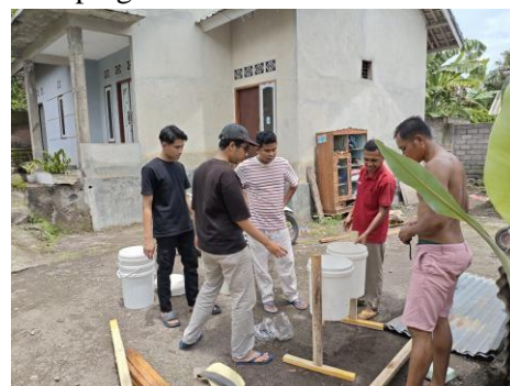
Gambar 3. Pembuatan Rangka Kayu
