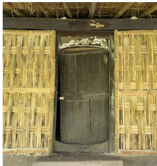
Gambar 3. Dinding dari anyaman bambu
