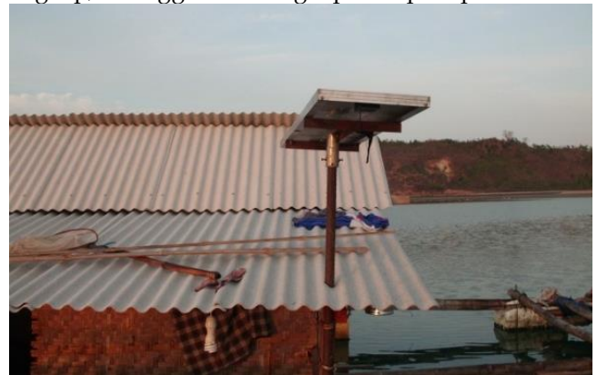
Gambar 5. Pengadaan Listrik Tenaga Surya
