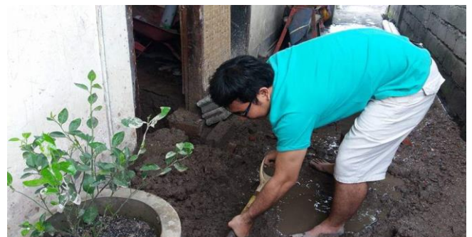
Gambar 3. Proses pembuatan saluran pembuangan residu
