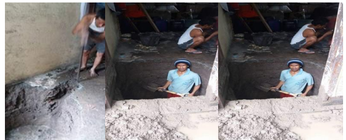
Gambar 1. Proses penggalian lubang untuk penanaman digester
